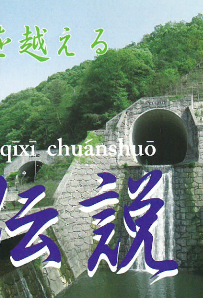
天野川放水トンネル
